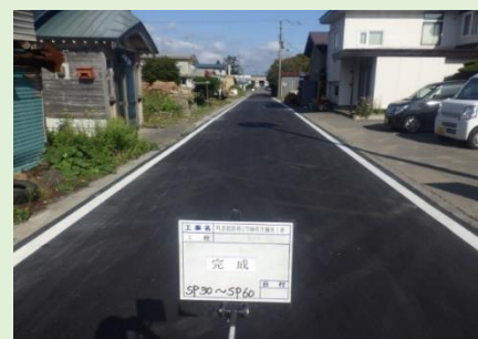
町道鹿部南2号線 道路整備後
