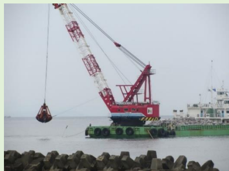
昆布繁茂場所を造成するための投石作業
