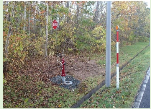
消火栓改修後
