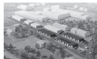
令和7年度は、湯の沢団地の解体工事を実施しました。令和8年度は、3棟12戸の住宅を建設予定です。 ※図はイメージです
