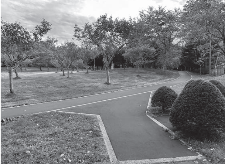
鹿部公園ウォーキングロードの舗装改修工事を実施しました
