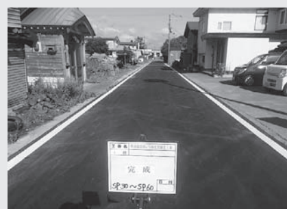
町道鹿部南2号線 道路整備後
