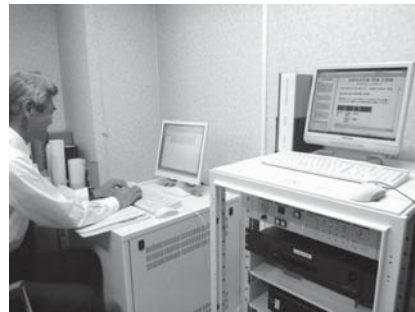
＜防災情報通信設備（自動起動装置等）の購入＞ インターネット回線を通じて、各携帯電話事業者のサーバーと接続することにより、全国瞬時警報システム(J-ALERT)と配信される緊急情報を瞬時に緊急速報メールにより地域内の住民等へ伝達できるようになりました。
