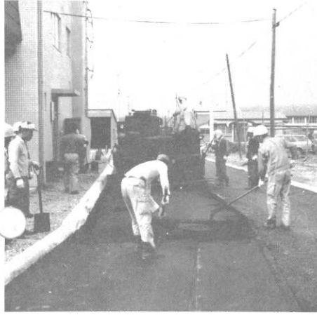
昨年の道路舗装工事
