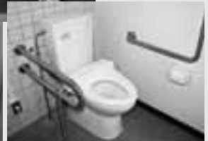
小学校トイレ改修工事 (スロープ設置等をした障害者用トイレ)
