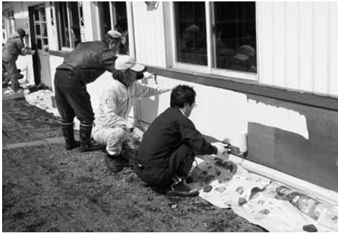
駅舎外壁の塗り替え作業
