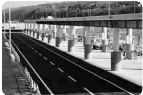
鹿部漁港西防波堤岸壁 天蓋施設完成
