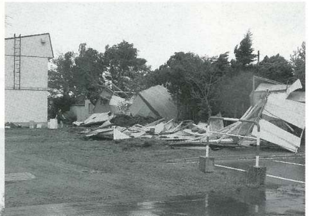
強風により、車庫が倒壊 (宮浜教職員住宅)
