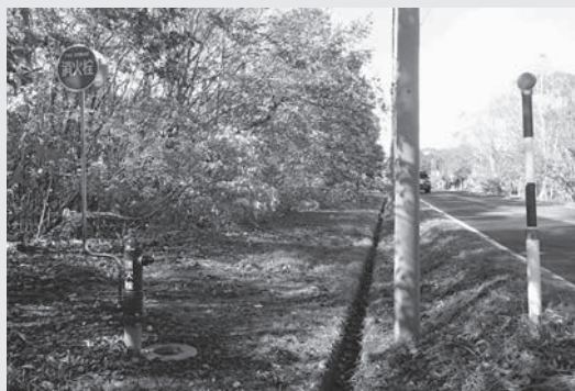
消火栓改修後
