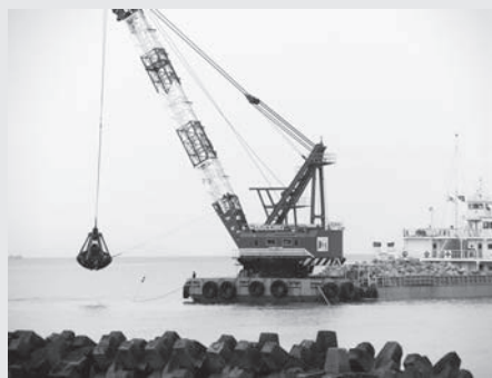
昆布繁茂場所を造成するための投石作業
