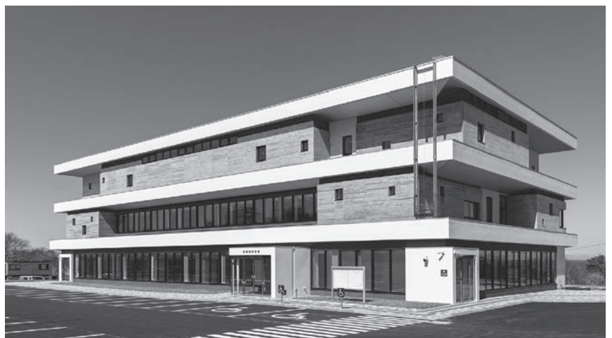
役場新庁舎建設工事
