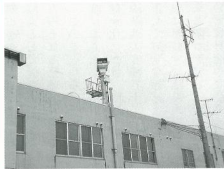
役場屋上に駒ヶ岳監視カメラ設置
