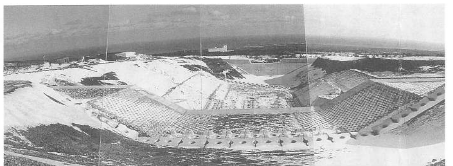
駒ヶ岳演習場障害防止対策工事 (押出沢砂防工事)
