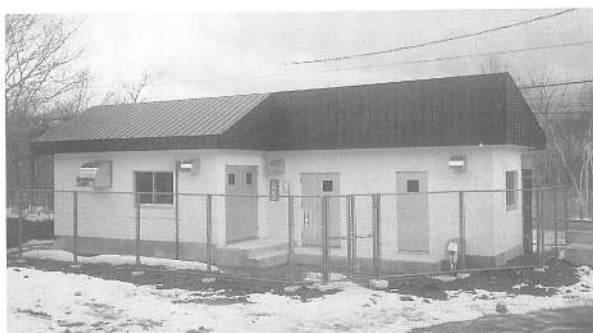
整備が行われた「やすらぎ地区給水ポンプ場」
