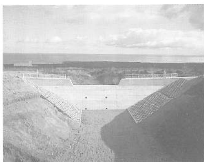
押出沢砂防工事
