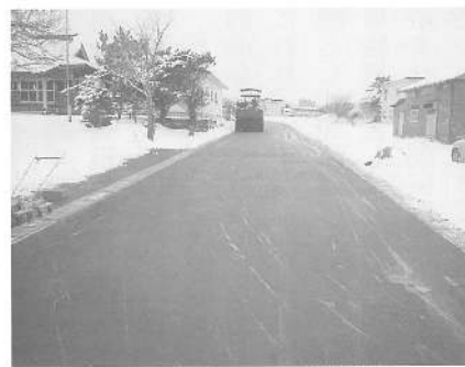
町道本別神社横道路線工事
