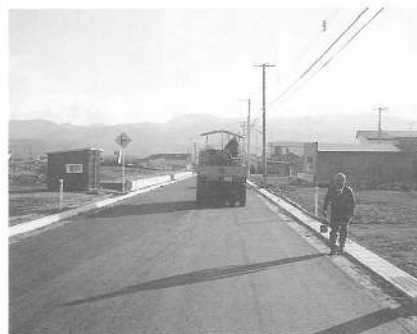
町道出来潤道路線改良舗装工事
