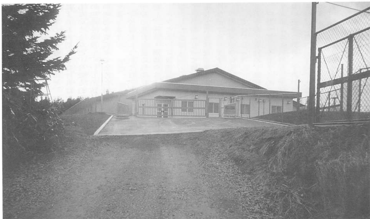
整備が行なわれた「鹿部町浄水場」
