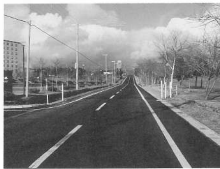
道路整備が終了した出来澗北11号線
