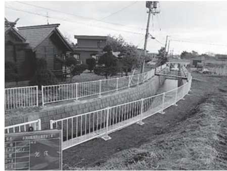
◀本別川転落防止柵更新工事（完成）▶
