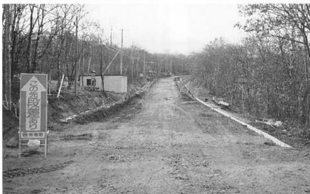
町道出来潤11号線凍雪害防止工事 11月末完成予定
