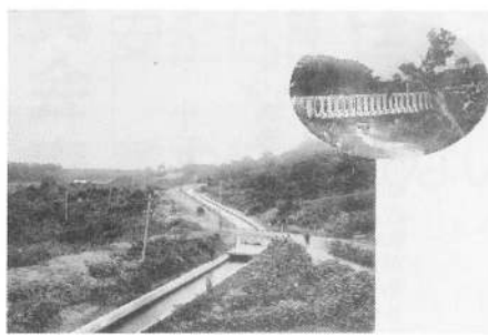
発電所水路橋と水路
