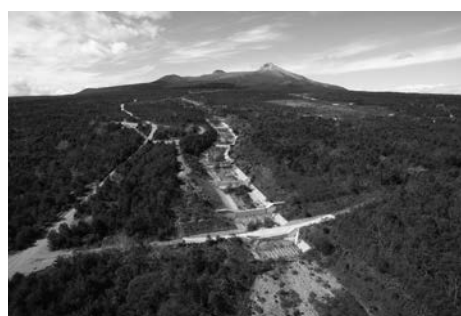
駒ヶ岳砂防施設
