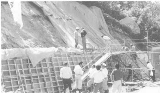
小規模治山工事箇所調査
