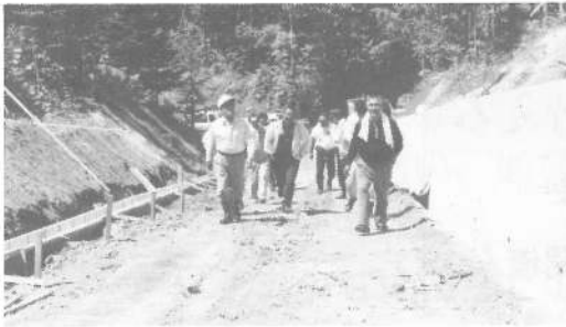
林道工事箇所調査
