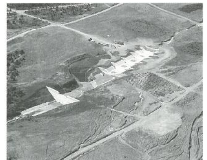
押出沢砂防ダム建設事業
