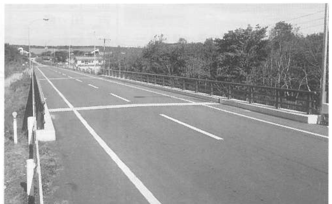
平成9年12月10日に完成した『留の沢橋』
