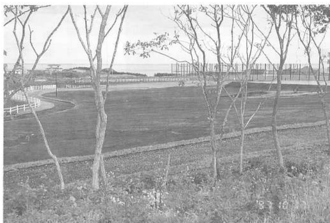
現在、整備中の「ひょうたん沼公園」です。平成12年度完成予定です。
