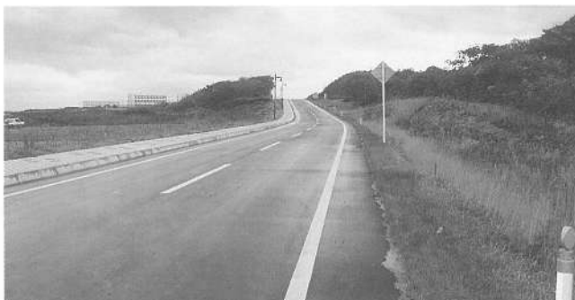
平成8年11月29日に完成した 『出来洞4号線』
