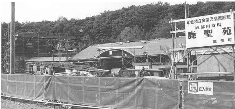
国民年金・厚生年金還元融資施設 只今建設中の斎場「鹿聖苑」
