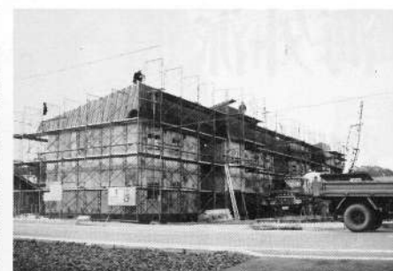
↑町営住宅2棟8戸建設 事業費 100,734千円
