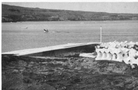
↑本別漁港出来潤分区突堤新設事業 (事業主体=北海道)
