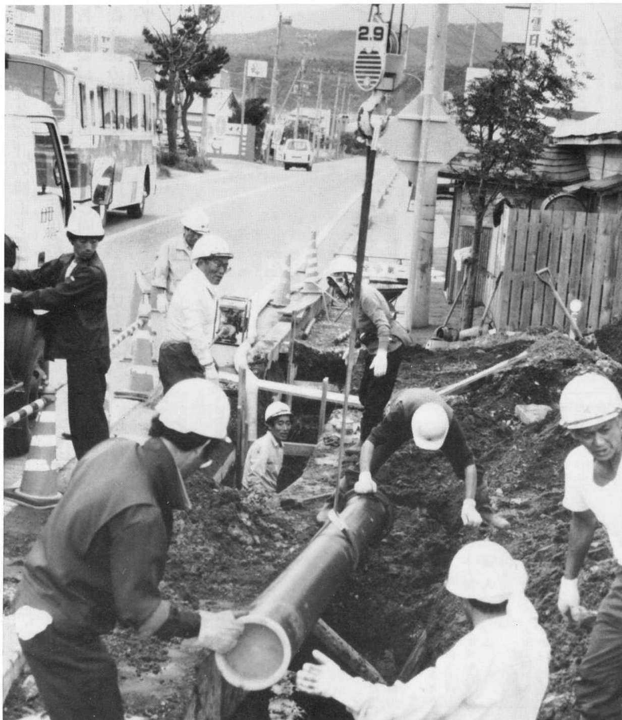
駒ヶ岳演習場周辺整備補助金を受け、着々と進む水道配水管布設工事
