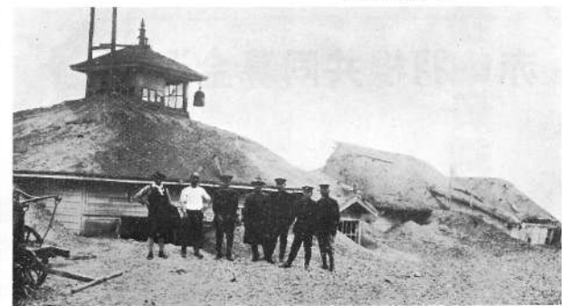
鹿部巡査駐在所の惨状
