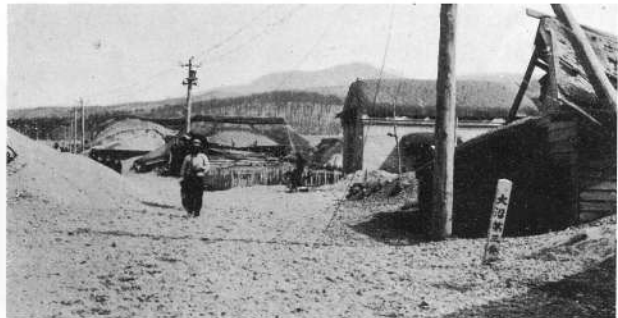
鹿部市街地裏通の惨状
