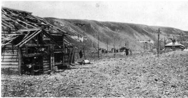
鹿部村小川尋常小学校の惨状
