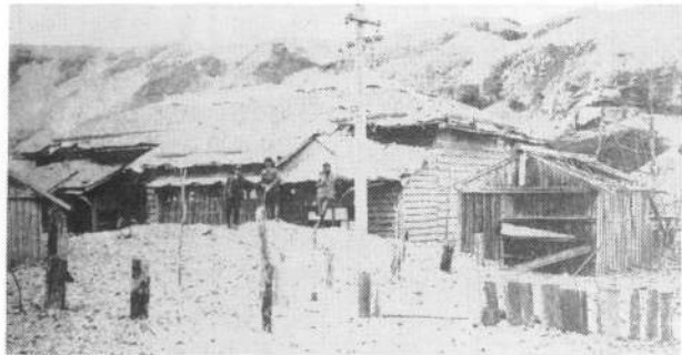
大沼発電所社宅
