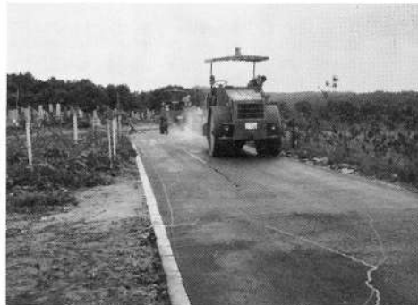
次は建設土木関係であります。
