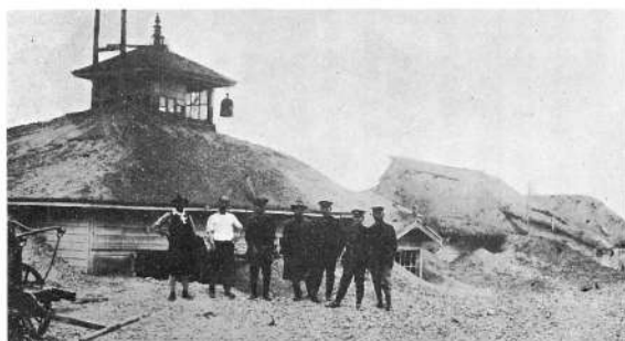
鹿部巡査駐在所の惨状
