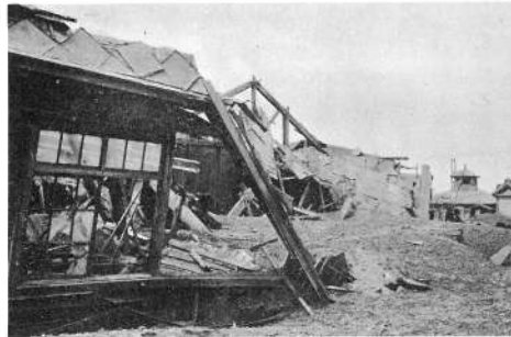
倒壊した鹿部小学校
