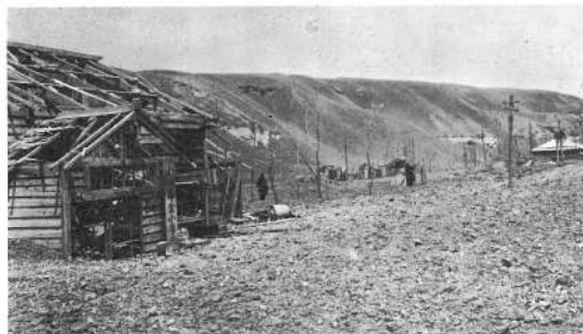
倒壊した小川小学校
