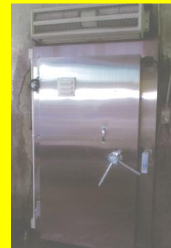
冷凍倉庫扉補修
