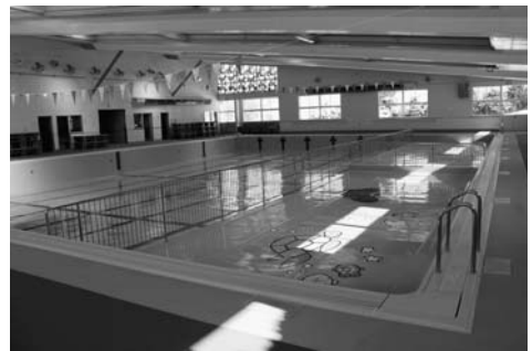
コミュニティ・プール水槽改修
