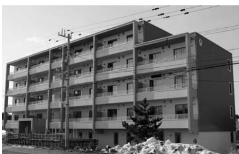
建設中のひまわり団地
