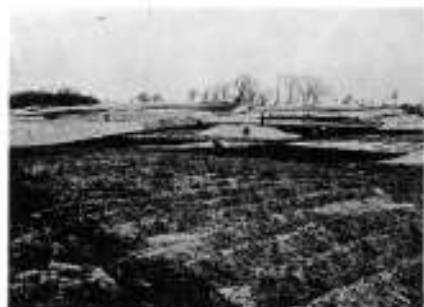
灰土除去作業
