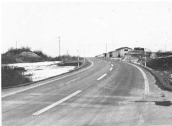
村道出来潤道路2号線 舗装工事
