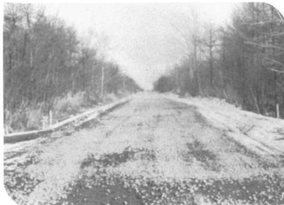
村道出来潤3号線 凍雪害防止工事
