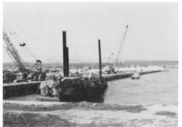
本別漁港拡張工事
