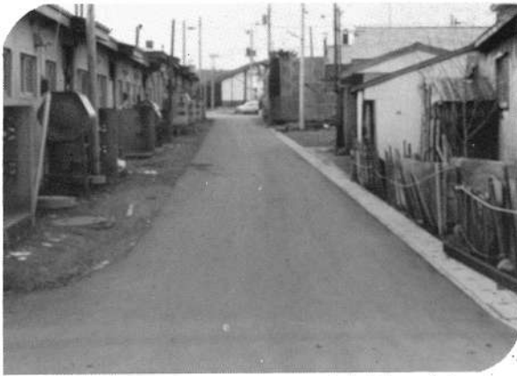
村道宮浜1号線 舗装側溝工事
