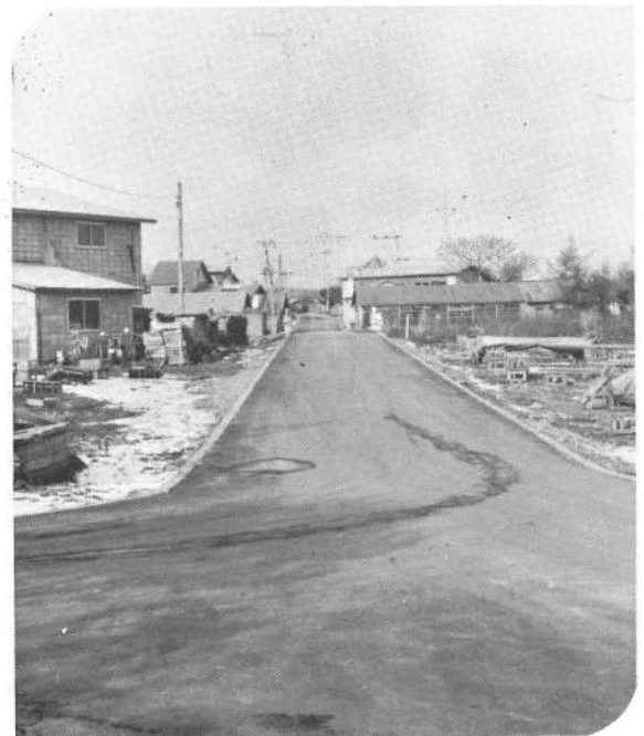
村道漁業組合横道路線 舗装工事
