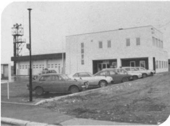
鹿部消防署庁舎
