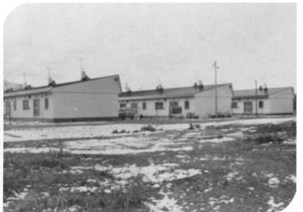
公営住宅 はまなす団地
