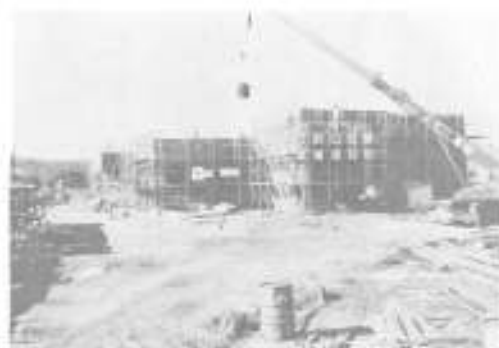
中学校建設風景
