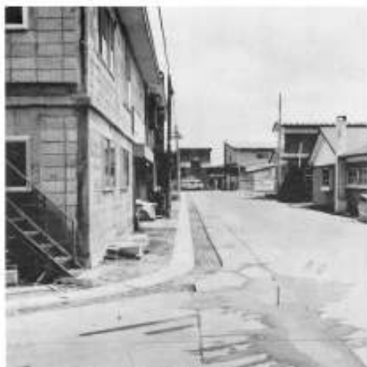
村道鹿部市街地測溝整備工事
