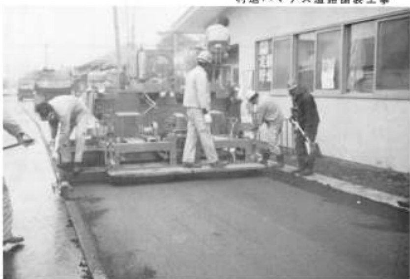
村道鹿部西5号線舗装工事
