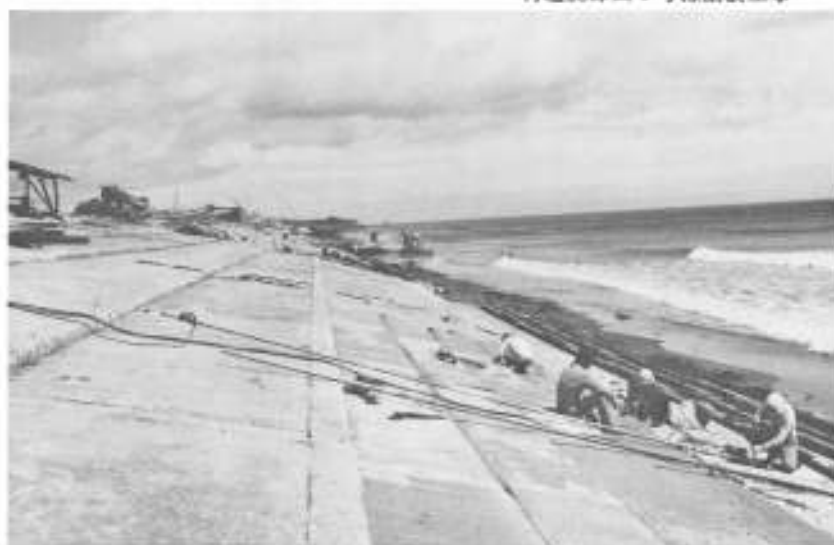
船揚場災害復旧工事
