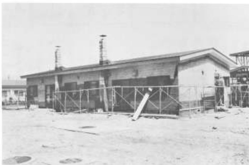
村職員住宅新築工事
