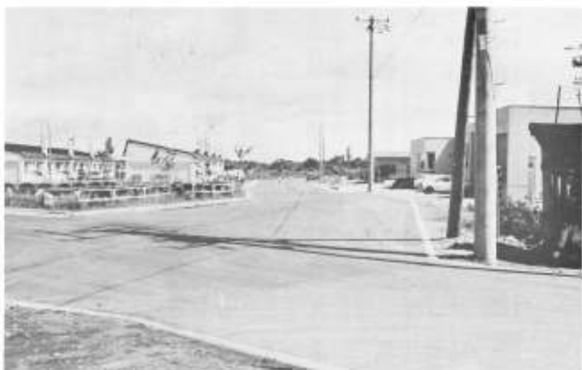
村道ハマナス道路舗装工事
