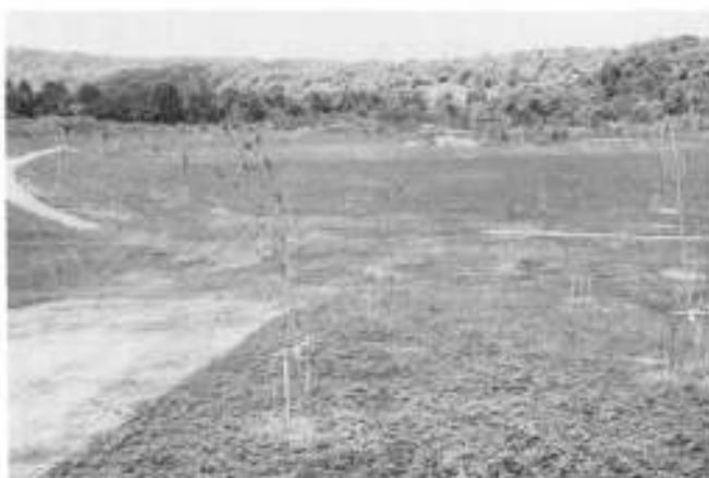
村民公園新設工事
