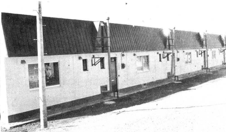
公営住宅建設工事(湯の沢団地)
