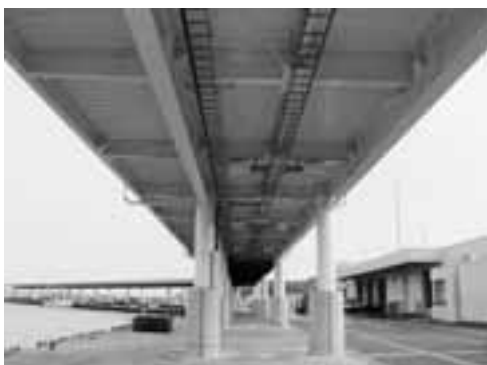
荷捌所前天蓋施設
