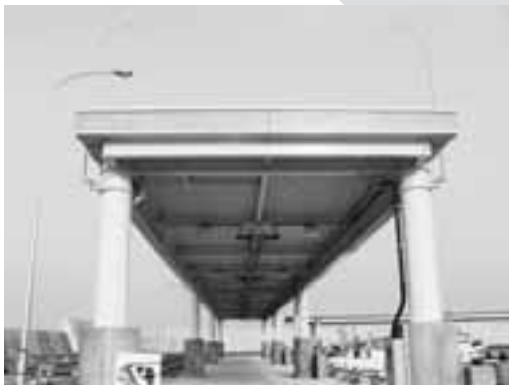
西護岸沖側天蓋施設
