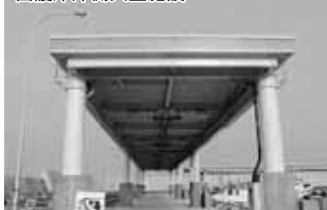
西護岸沖側天蓋施設
