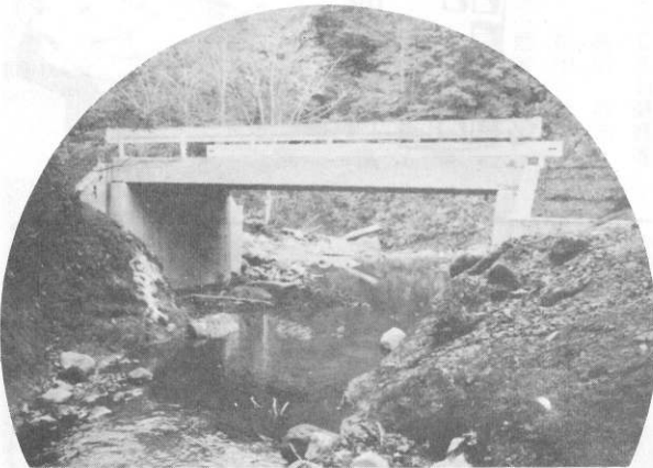
常呂林道架橋 延長 10 m
