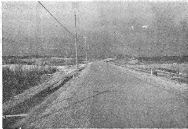
出来潤道路改良工事 (1,065m巾員4m)
