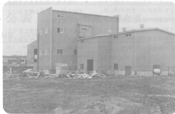
建屋工事部分が完成したごみ処理施設
