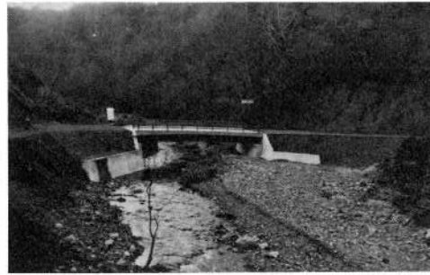
▶常呂林道橋(1号)架換工事 請負金額 7,793千円 鈴木事業所
