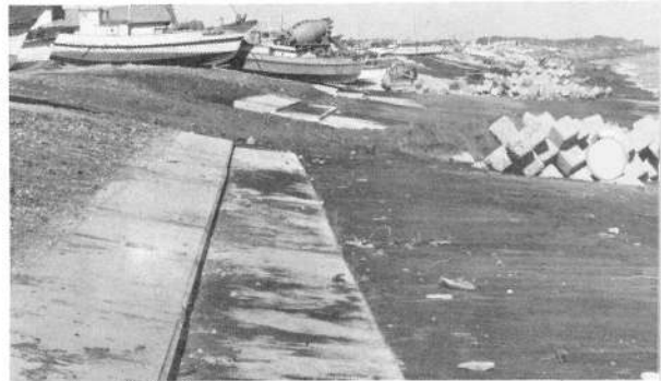
本別地区漁船漁具保全施設
