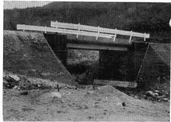
完工なつた冷水川林道と永久橋
