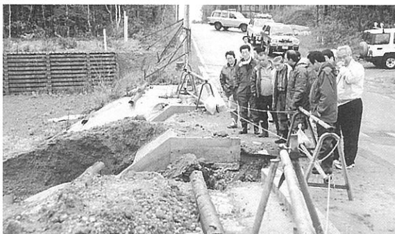
大和ハウス分譲地内 美駒平沈砂池
