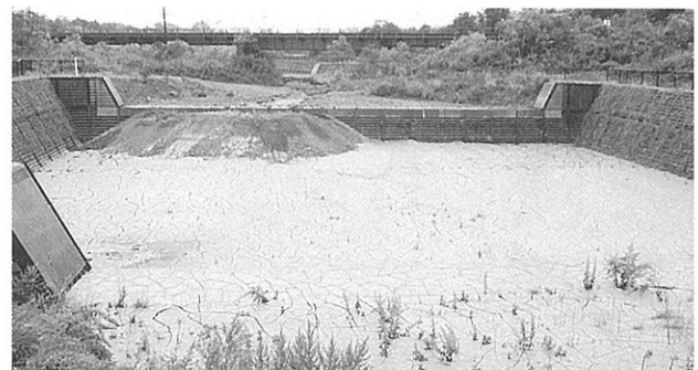
大和ハウス分譲地内 美駒平沈砂池
