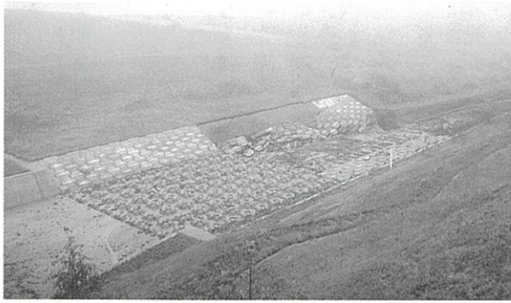
押出沢川 2 号ダム
