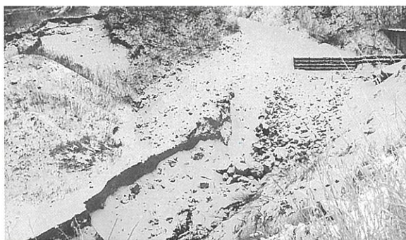
大雨により決壊した尻無川
