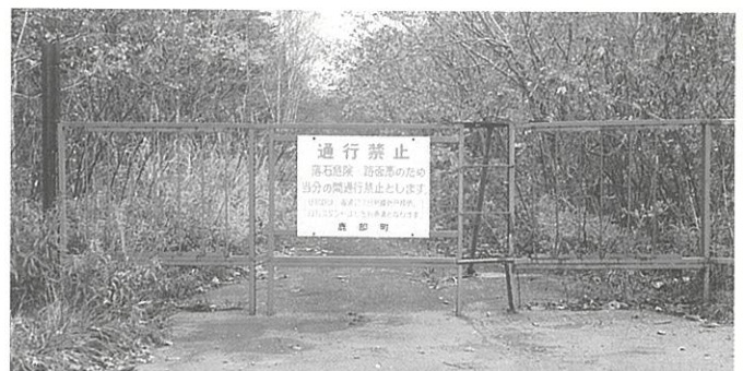
通行止め中の町道「留の沢5号線」
